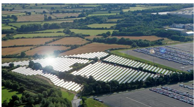
TMUKの太陽光パネル
