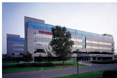
TMEの本社ビル
