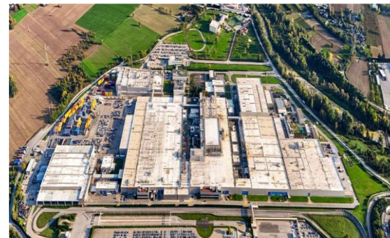
Factory of TMMT
