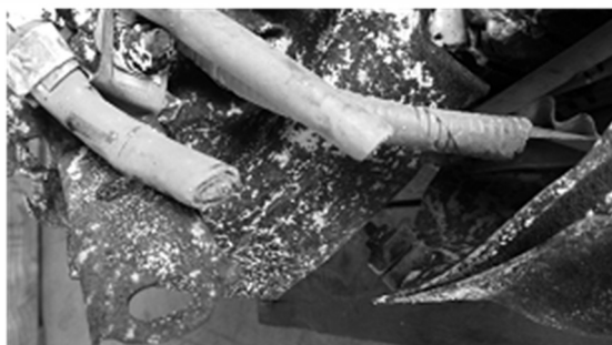
高電圧回路のケーブル類オレンジ色を切断したもの
