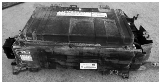
屋外に長期間放置されて損傷が激しいもの
