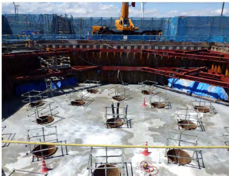
写真 1.5-2 風力発電機の基礎の建設工事状況 (WT1)
