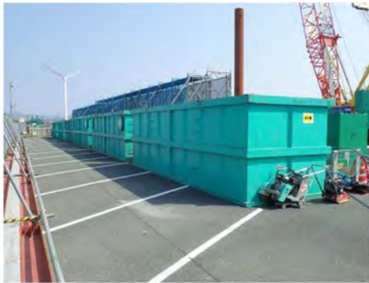
濁水処置設備群（沈砂槽）
