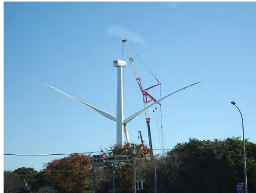
写真 1.4-1 風力発電機の組み立て (WT4)
