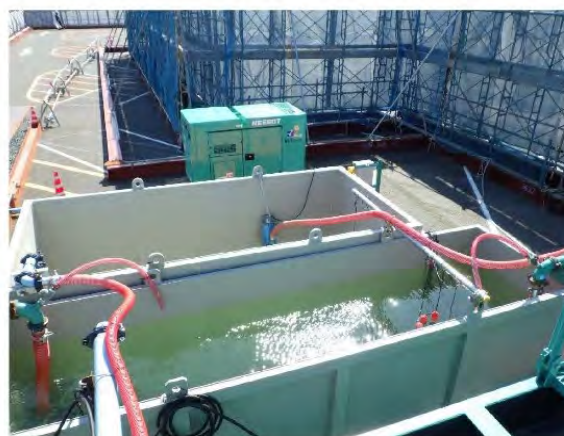
濁水処理設備（放流槽）
