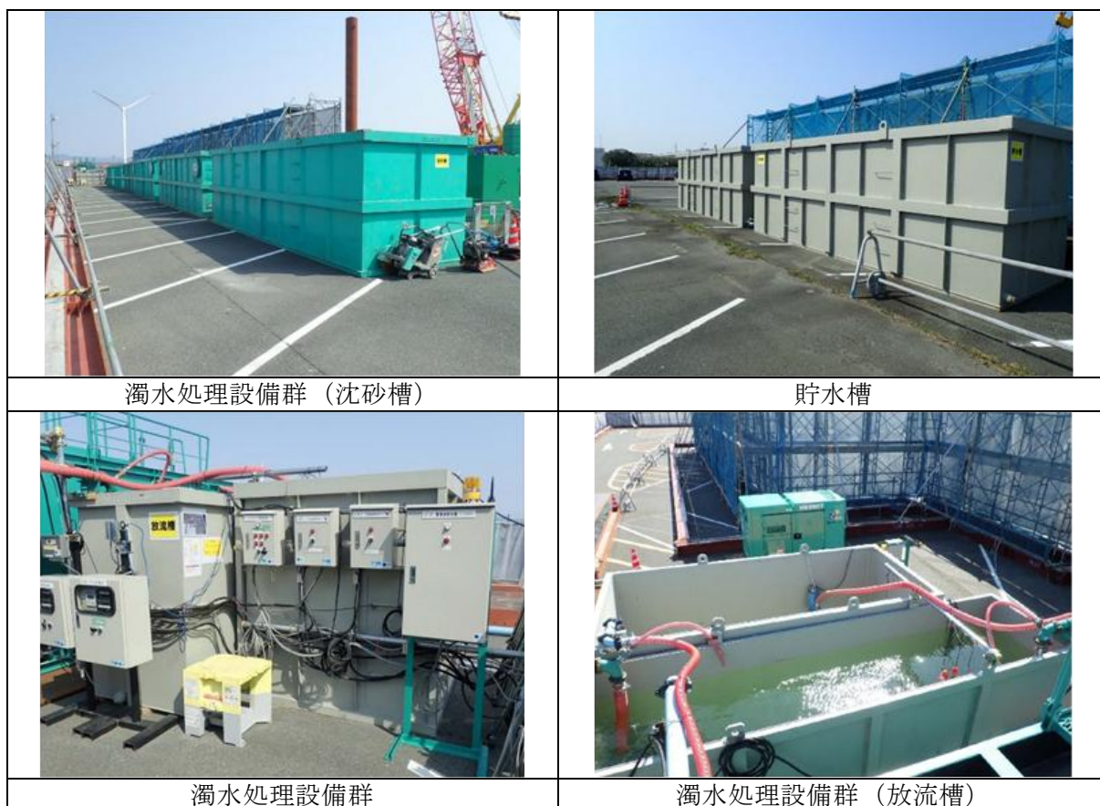
図 2.2-12 濁水処理設備等
