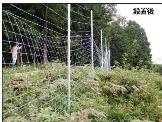
写真2 敷地境界付近に設置した獣害対策フェンス
