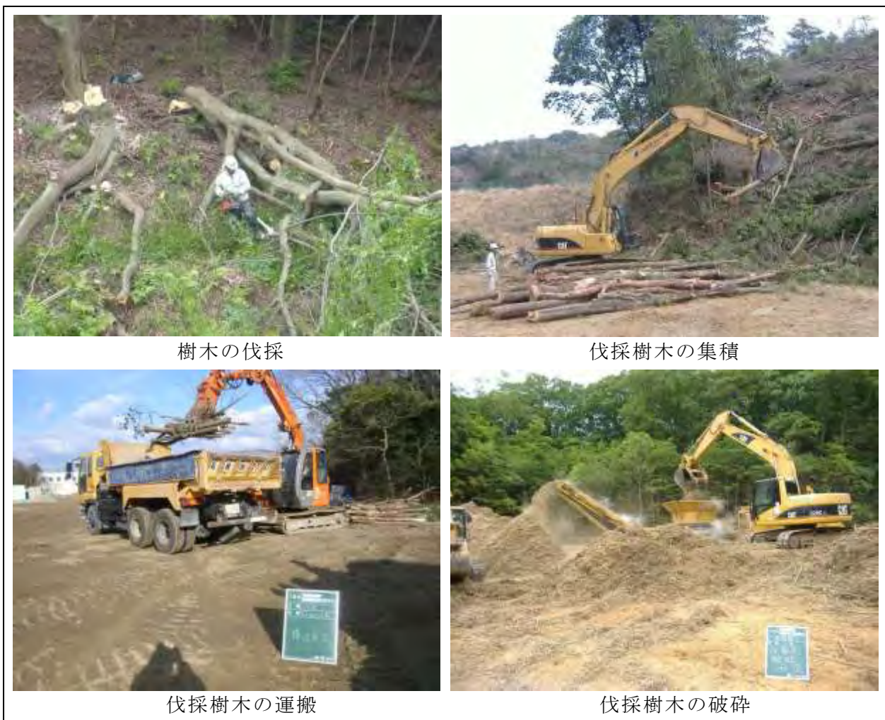
図 2-13 伐採工事例の写真
