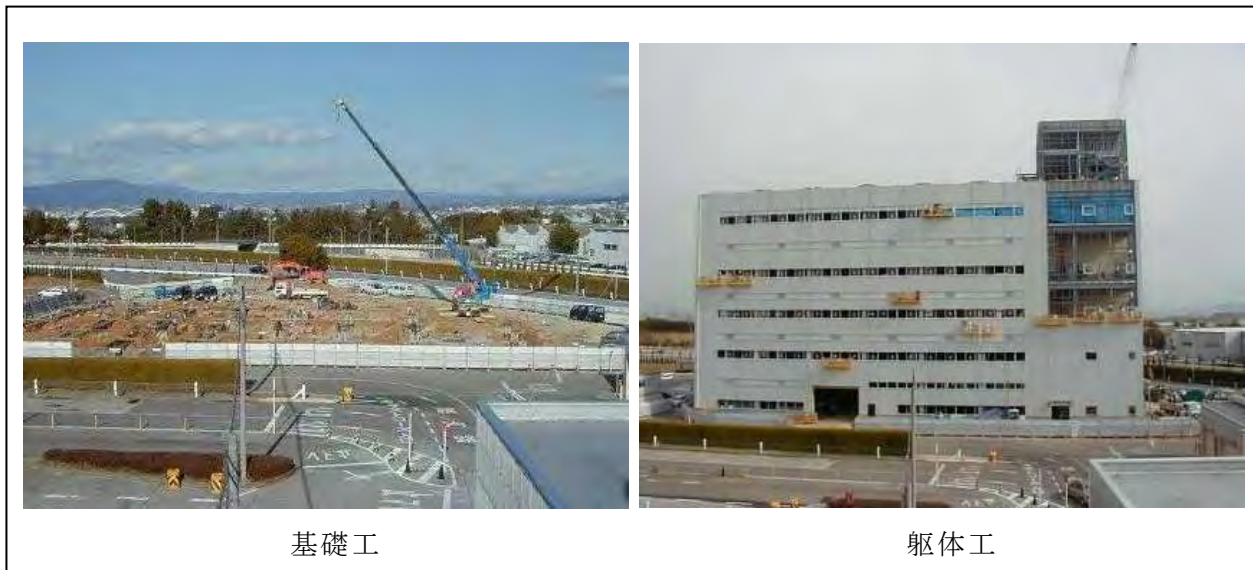
図 2-21 建築工事例の写真
