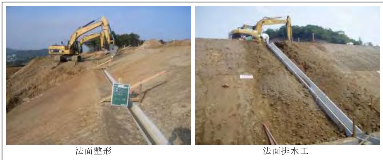
図 2-17 法面工事例の写真
