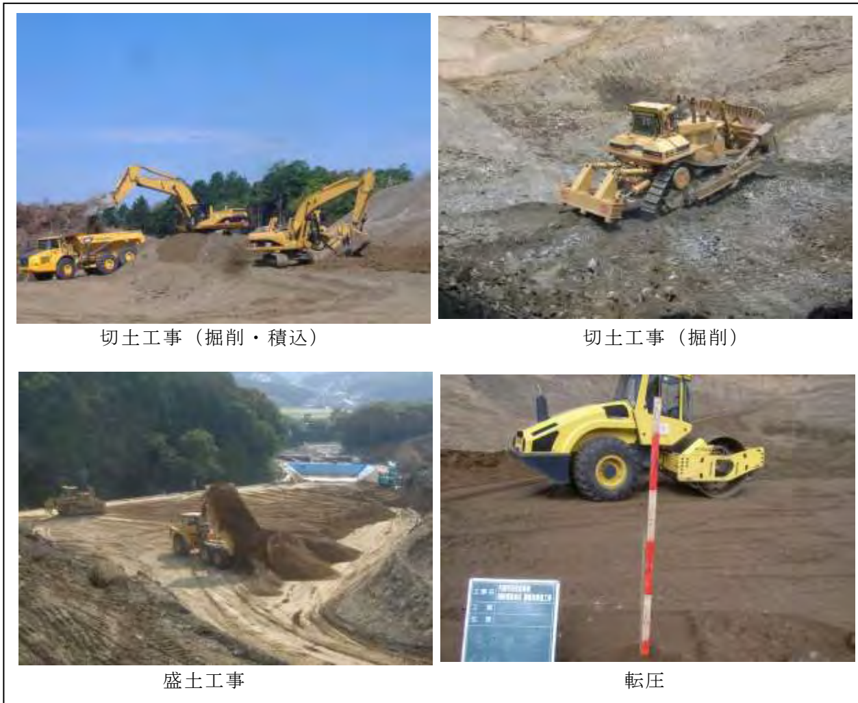
図 2-14 土工事例の写真
