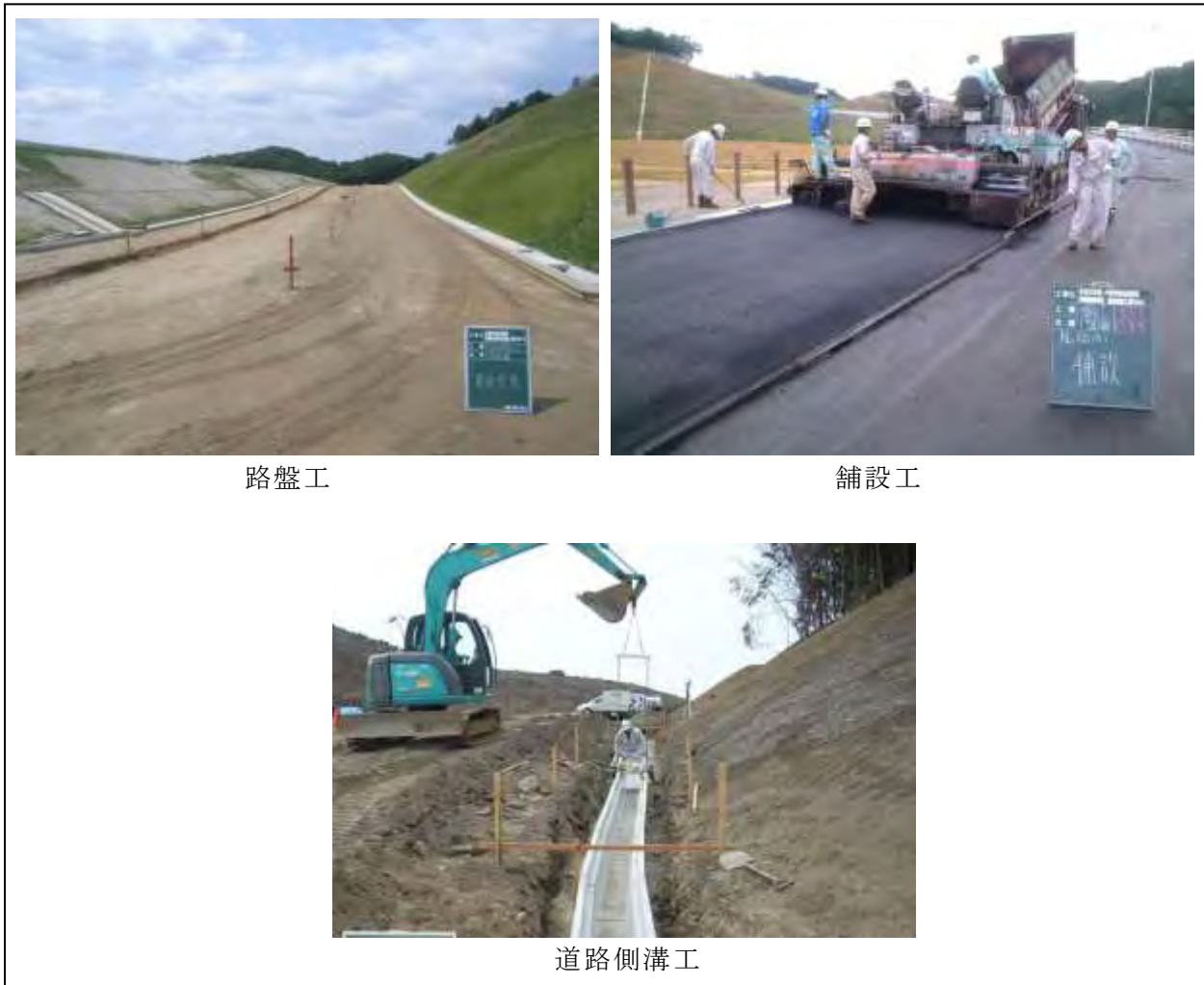
図 2-20 道路工事例の写真
