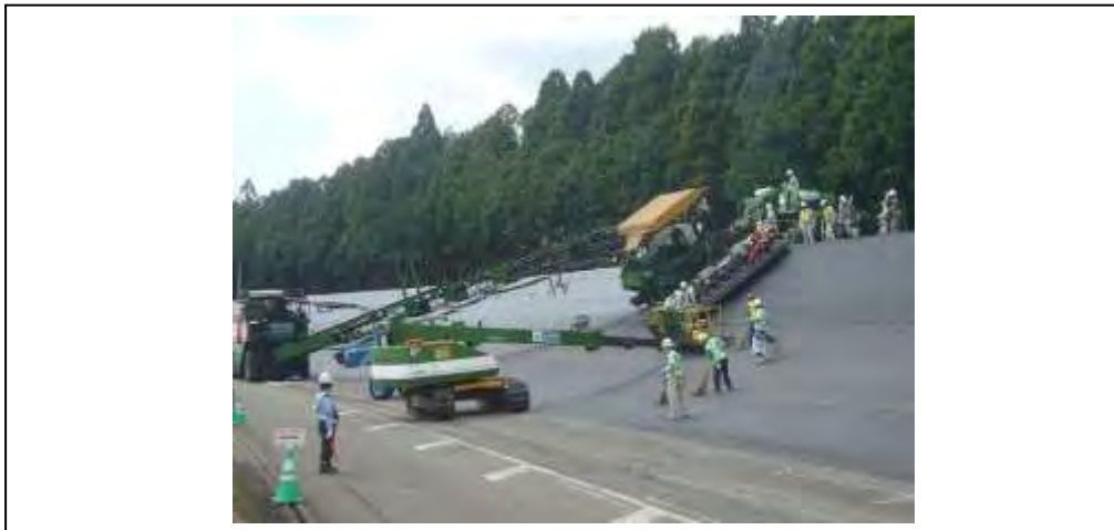
図 2-22 舗装工事例の写真
