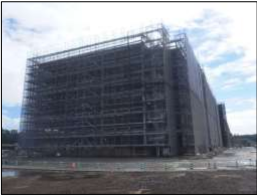
③施設建設工事 (建築工事、2023 年 6 月)
