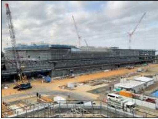
①施設建設工事 (建築工事、2023 年 1 月)
