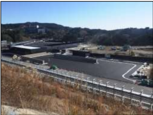
⑤施設建設工事 (建築工事、2023 年 6 月)
