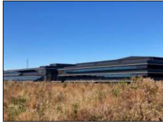
④施設建設工事 (建築工事、2023 年 6 月)
