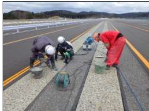
⑥施設建設工事 (舗装工事、2023 年 1 月)
