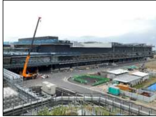
②施設建設工事 (建築工事、2023 年 6 月)
