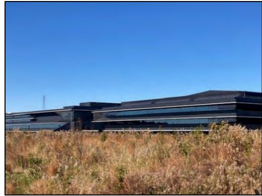
④施設建設工事（建築工事、2023 年 6 月）
