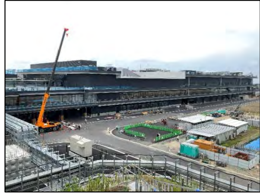
②施設建設工事（建築工事、2023 年 6 月）
