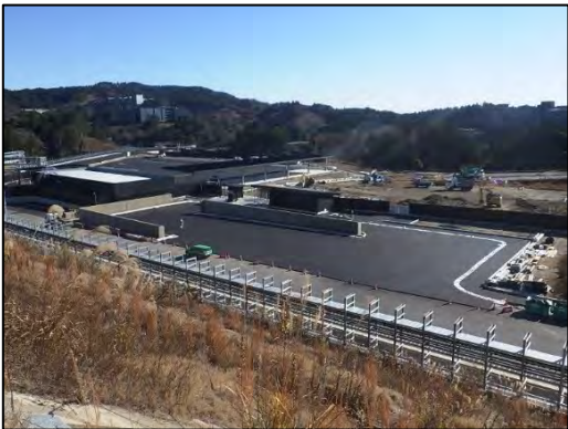
⑤施設建設工事（建築工事、2023 年 6 月）
