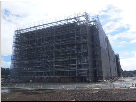
③施設建設工事（建築工事、2023 年 6 月）
