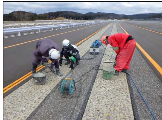
⑥施設建設工事（舗装工事、2023年1月）
