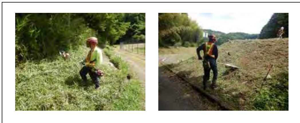
図 3-5 草刈作業の実施状況（施設完成後 1 年目）
