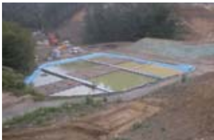
工所用仮設沈砂池の設置
