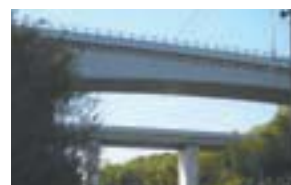
橋梁による地形の保全
