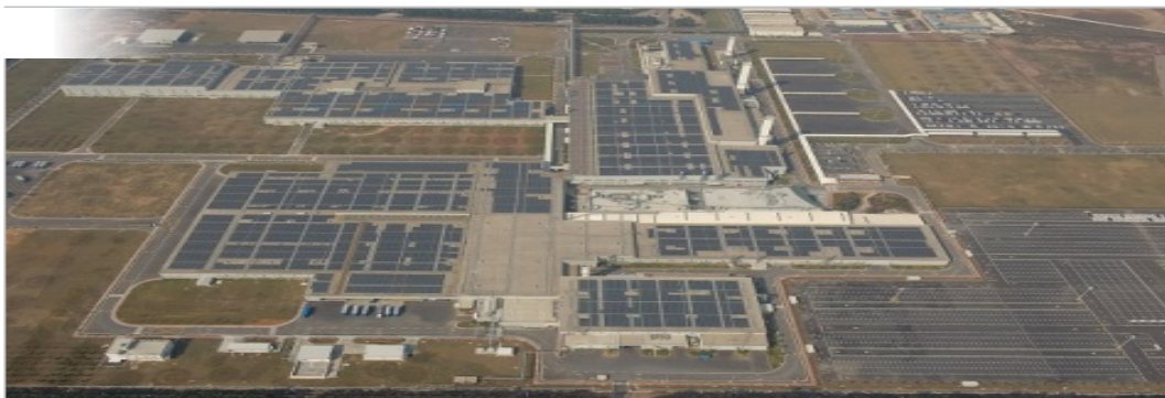
車両工場（10MW）
