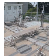
排水処理施設
