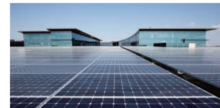
TMNA 北米新本社屋 (建屋に設置された太陽光パネル)
