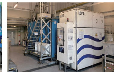
液体廃棄物の蒸発システム
