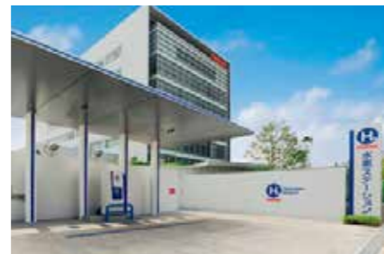
尼崎水素ステーション
