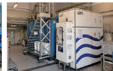
液体廃棄物の蒸発システム
